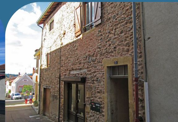
3 rue de Bise Villerest
